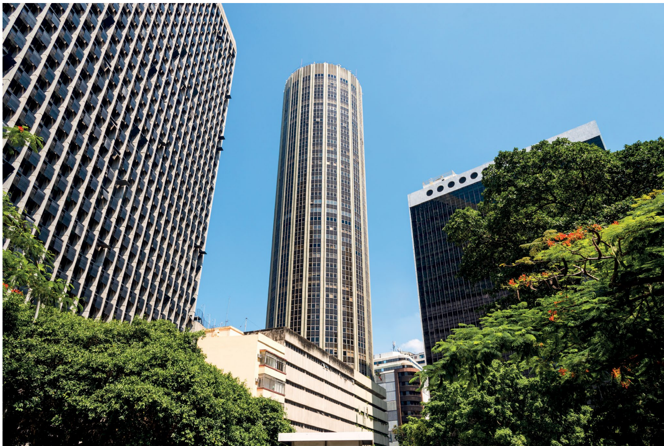
Edifício Santos Dumont
